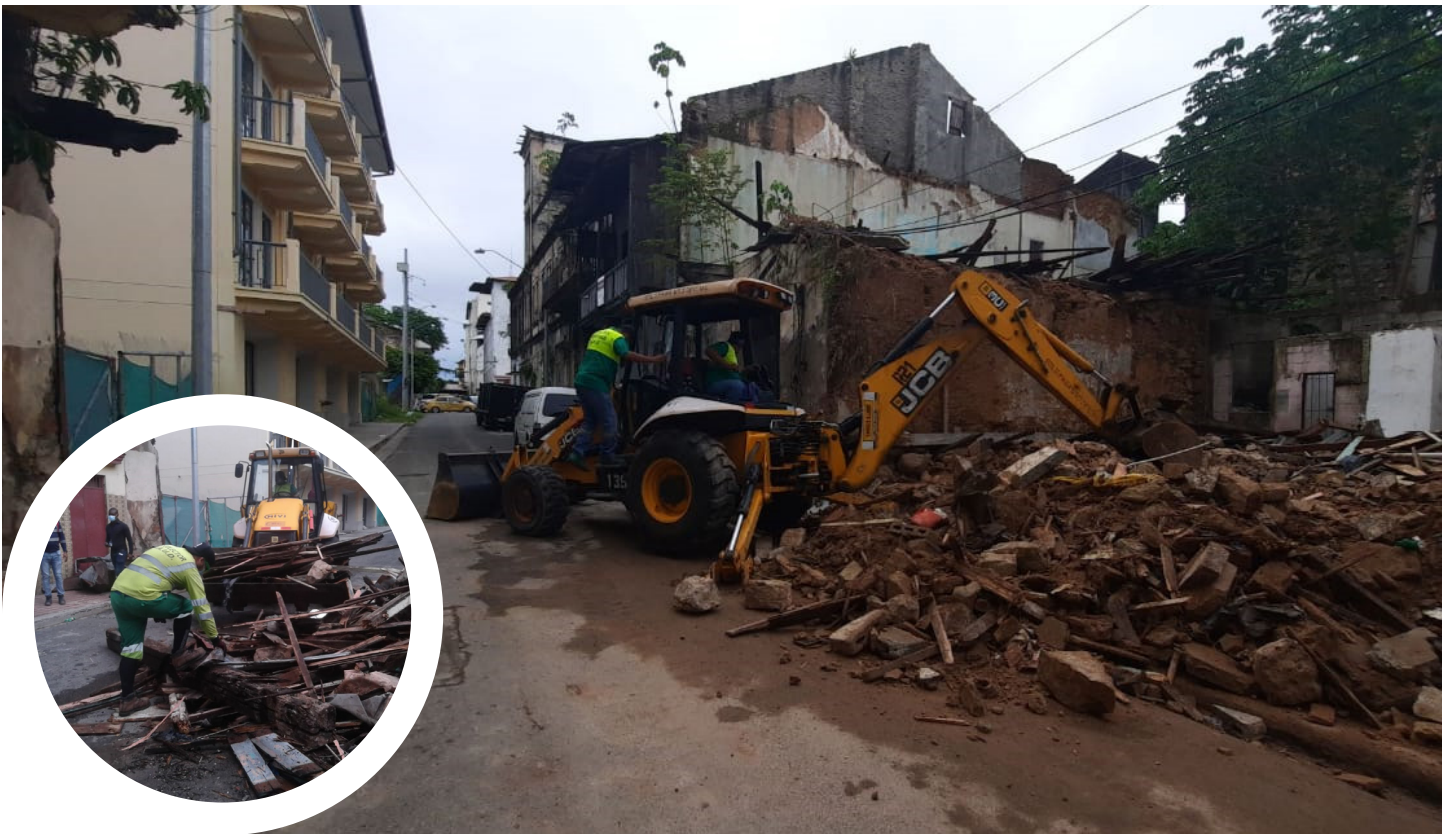
Trabajos de remoción de escombros en Calle 14 Santa Ana
